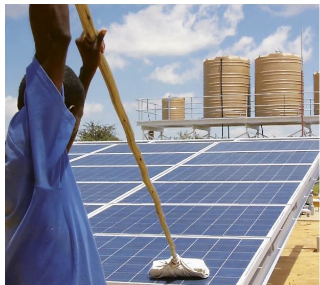
Entsalzungsanlage: Reinigung des Solarpanels
